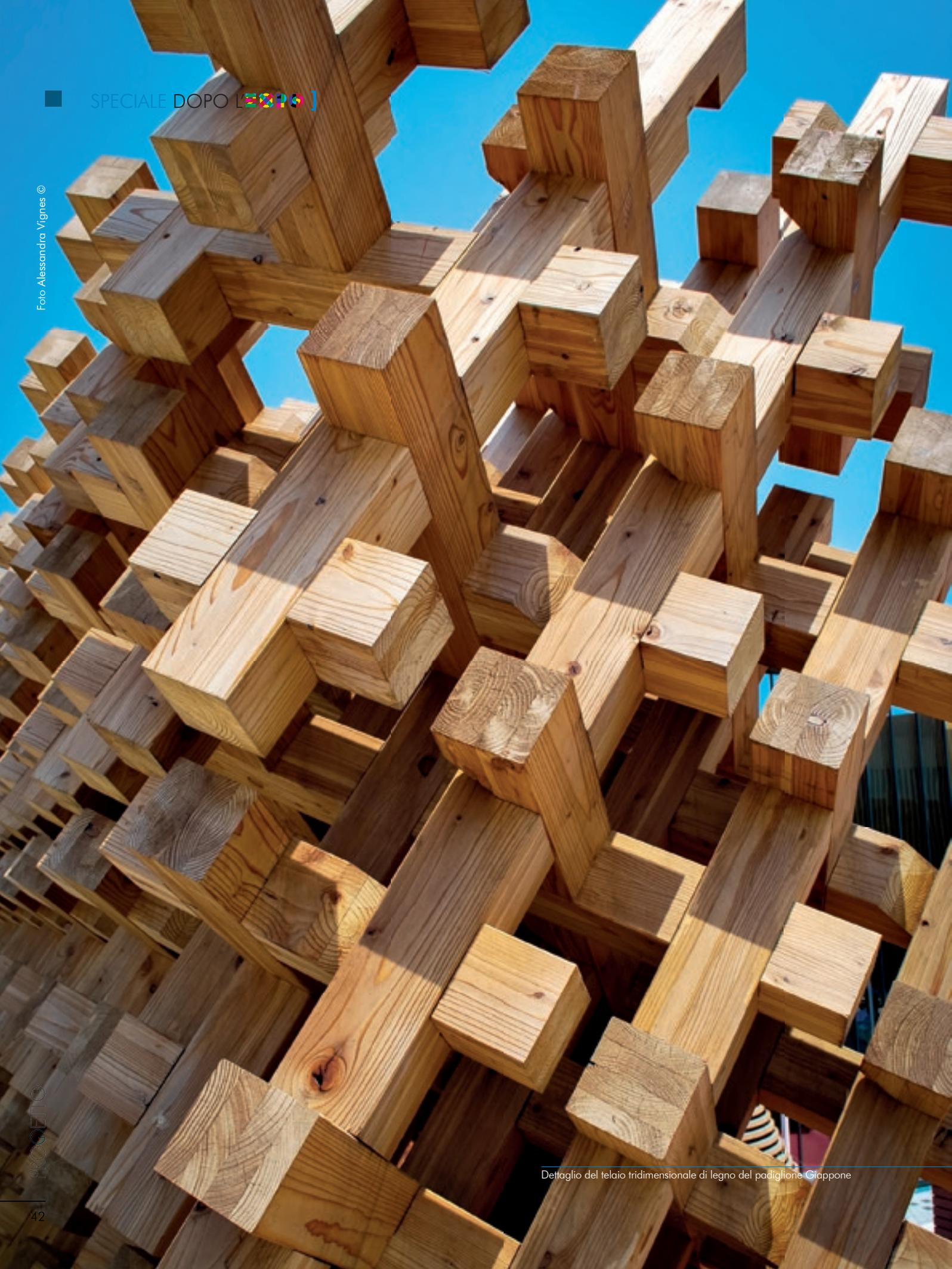
Dettaglio del telaio tridimensionale di legno del padiglione Giappone
